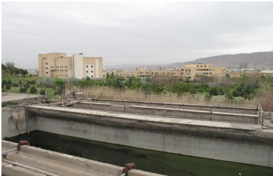
شکل ۱۵- سیستم تصفیه پساب جهت استفاده در آبیاری فضای سبز
