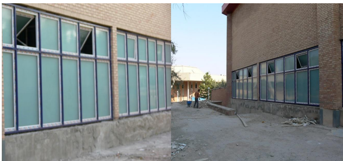
شکل ۱ - پنجره های اجرا شده دوجداره استخر دانشگاه
